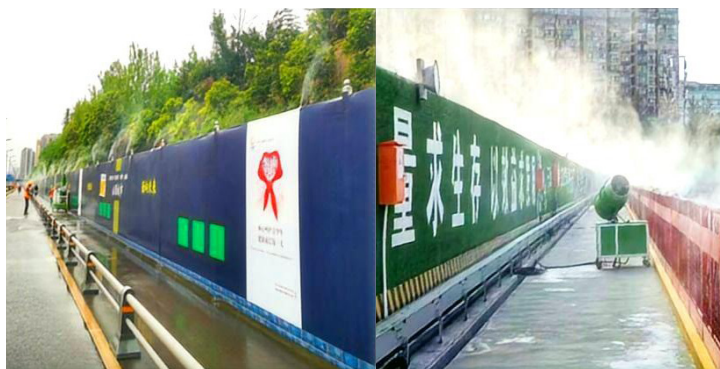
图 2-21 围挡喷淋和基坑喷淋示意图
