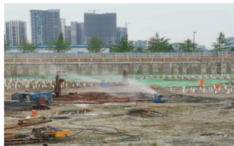
图 8-3 基坑作业区域增设雾炮
