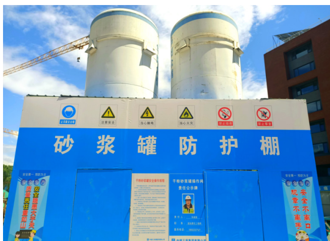
图 8-7 现场密闭预拌砂浆棚
