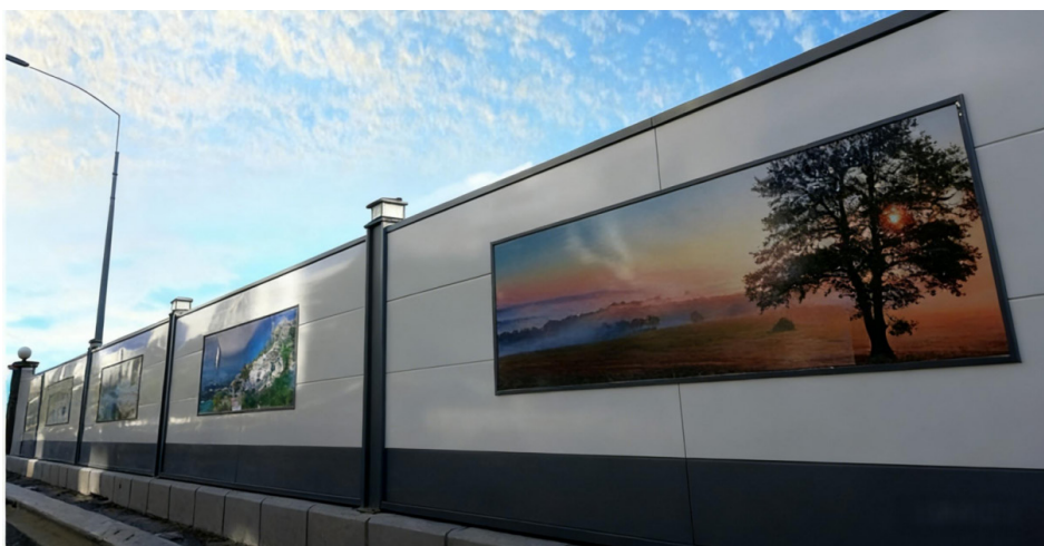
图 2-1 现代风格钢结构装配式围挡示意图
