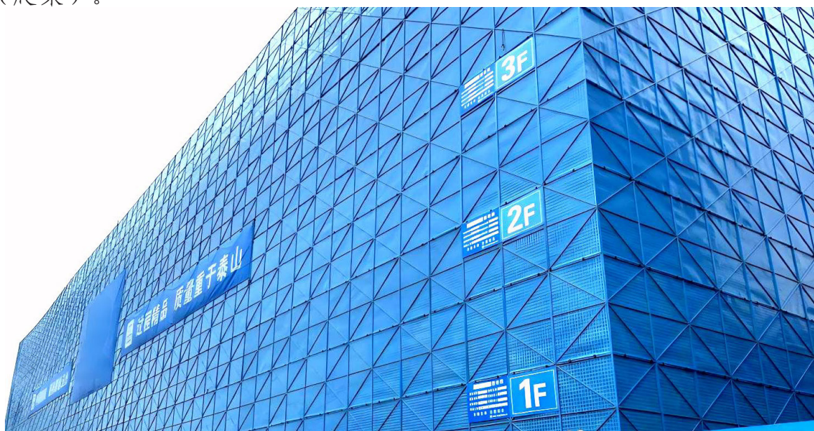
图 7-1 冲孔钢板网防护示意图
