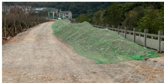
图 8-14 现场砂石等易扬尘材料堆放覆盖
