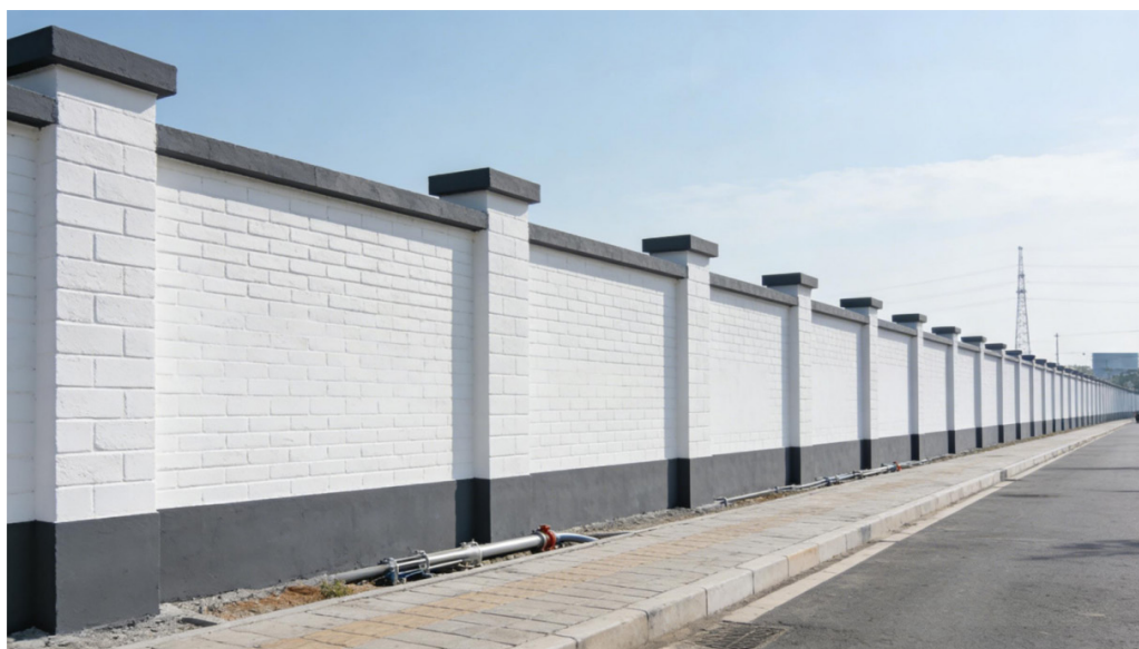
图 2-5 砖砌式围挡示意图
