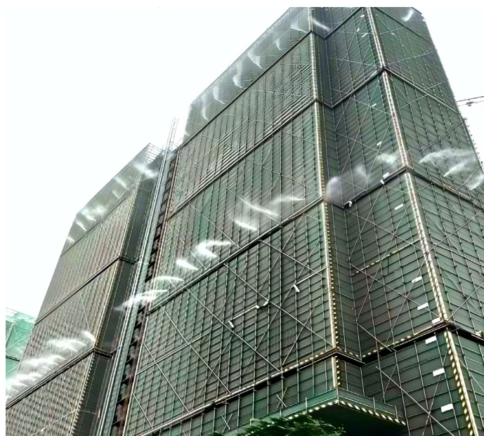
图 2-19 楼层四周设置喷淋装置示意图
