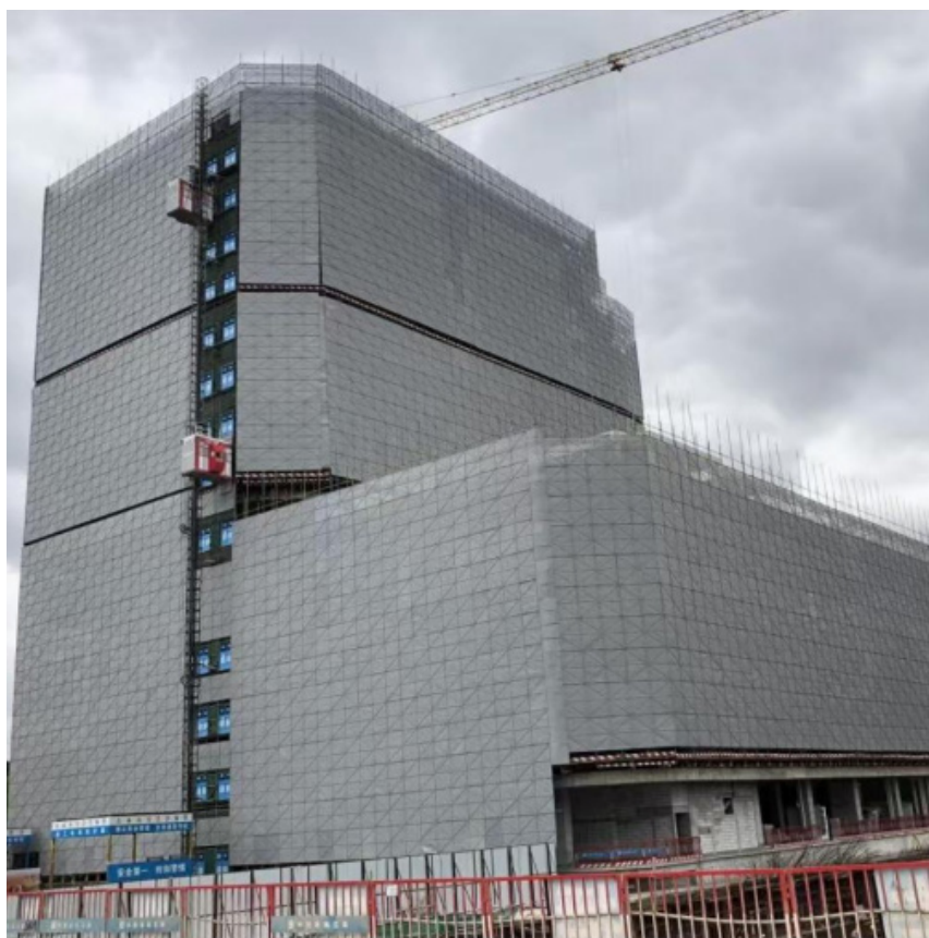
图 7-3 灰色冲孔钢板网防护示意图
