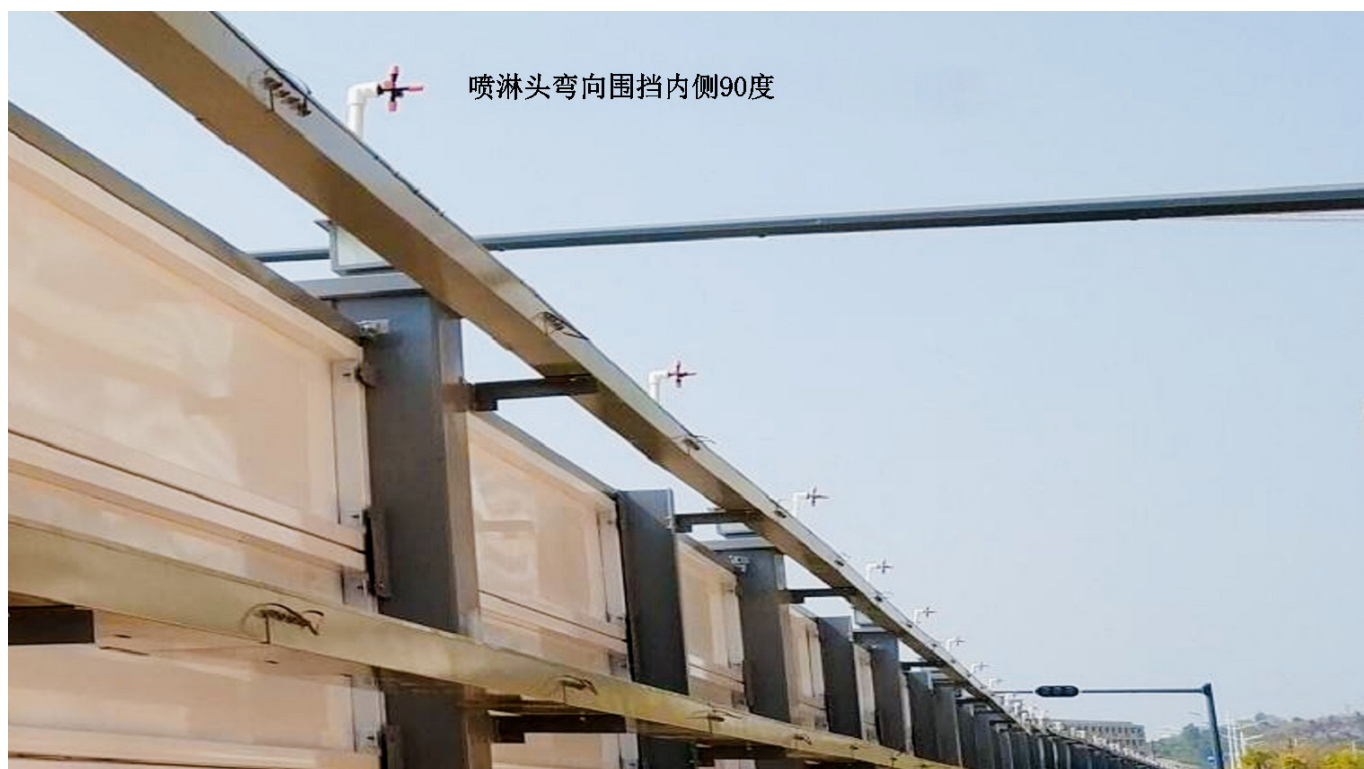
图 2-22 围挡喷淋设施示意图
