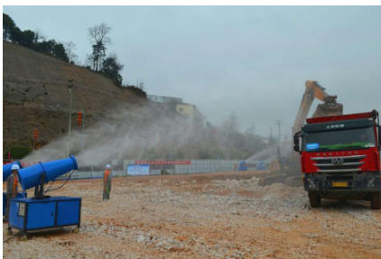
图 8-2 土方湿法作业示意图
