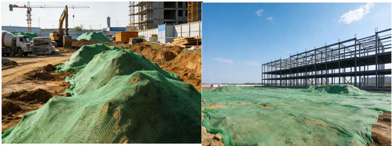
四、扬尘防控“六个 100%”要求：施工单位应当严格执行做到“六个 100%”，工地 100%围蔽、堆放物料 100%覆盖、施工现场地面 100%硬底化、出场车辆 100%车辆冲洗、行车路面及易扬尘工序 100%洒水降尘、长期闲置裸土区域 100%绿化）。要重点关注高空作业扬尘防治情况，要确保密目式安全立网的严密、清洁，及时清洗网上的污渍，各楼层应做好洒水方案，确保湿润不起灰尘。确因施工需要进行切割作业时，宜采用湿式作业法进行过水切割，并确保切割机护罩完好且正常使用。对易产生大量扬尘的切割作业，必须单独设置封闭式作业间。
