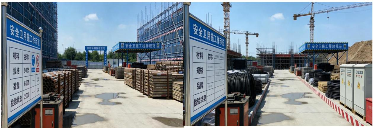
**三、施工物料及建筑垃圾管理要求：**应使用预拌制混凝土及预拌砂浆。经批准现场搅拌混凝土或砂浆的场所应采取封闭、降尘、降噪措施。水泥和其他易飞扬的细颗粒建筑材料应密闭存放或采取覆盖等措施。建筑土方、建筑垃圾应当及时清运；在场地内堆存的，应当采用符合标准的密闭式防尘网遮盖。建筑物内垃圾应采用封闭式管道或装袋用垂直升降机械清运，严禁凌空抛掷。施工现场严禁焚烧各类废弃物。土方和建筑垃圾的运输必须采用封闭式运输车辆或采取覆盖措施。
