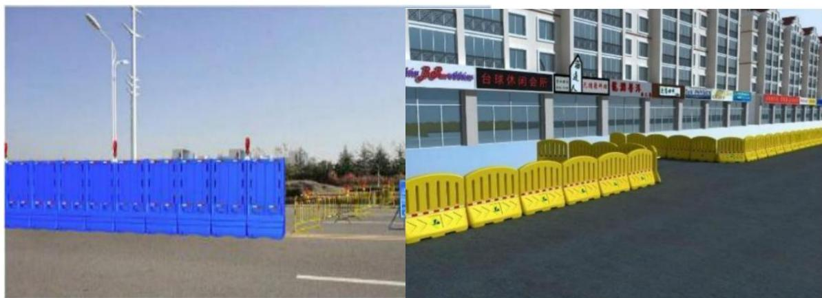
(三) 工程施工工期在一个月以下的市政工程,应采用塑料水马或者护栏围挡连续设置。塑料水马高度不低于0.8米,护栏高度不低于1.1米。围挡根据实际情况,在存有交通安全隐患的危险位置安装爆闪警示灯,警示灯立在围挡顶部。
