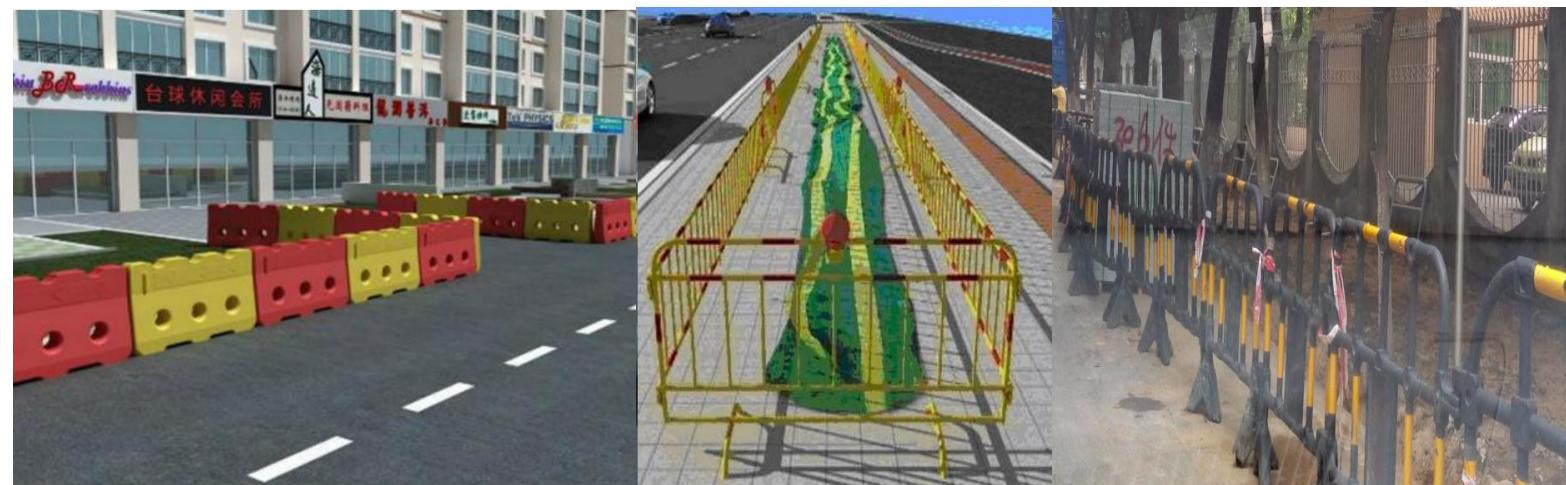
（四）围挡的设置必须沿工地四周连续围蔽，避免存在缺口，采取有效措施防止工地内污水外流。
